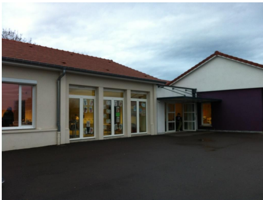
Nouveaux locaux réservés au périscolaire sur le site scolaire de Martigny-les-Bains
