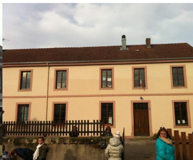
Ecole-Accueil périscolaire de La Bourgonce
